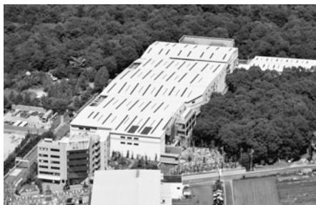
環境に配慮した全天候型の資源再生プラント
