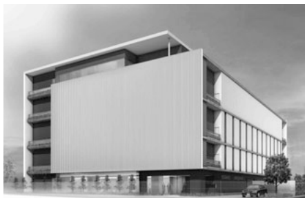
クラウドサービスを提供するデータセンター
