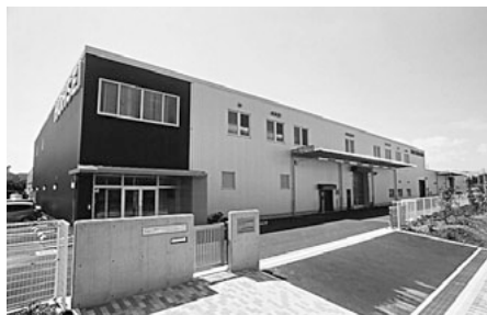
2004年竣工 坂戸本社外観
