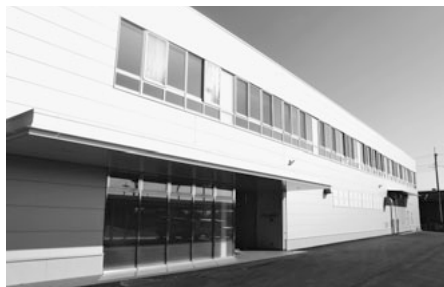
本社の2倍・狭山台第2工場が竣工しました。
