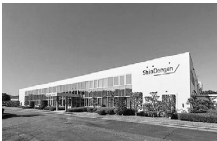
本社 第一工場外観
