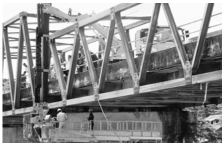
橋の下にアプローチする橋梁点検車
