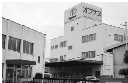
当社埼玉工場の外観写真です
