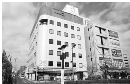
武蔵野本社ビル
