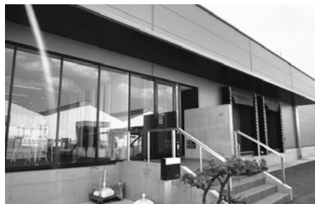
最新設備・ノウハウが詰まった本社工場です
