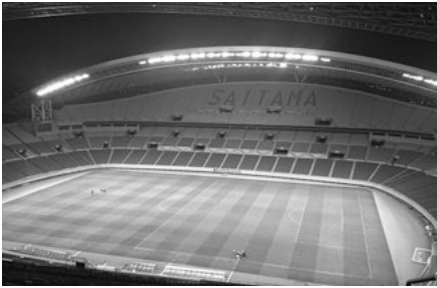
埼玉スタジアム2002 ピッチ照明工事
