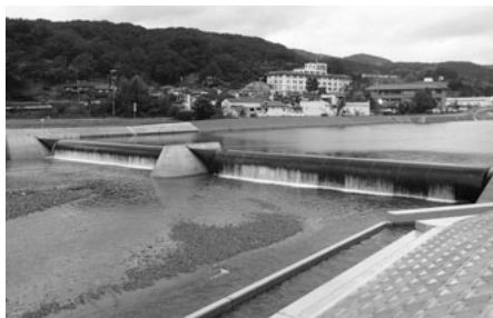
空気で膨らむラバーダム(ゴム製の可動堰)
