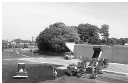
土木工事施工現場
