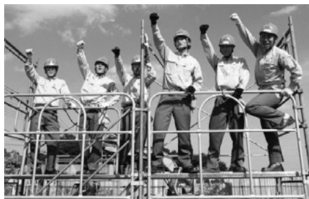
新入社員研修、足場組立完成。
