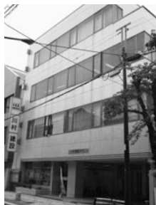
内装リフォームの綺麗なビルに引越し
